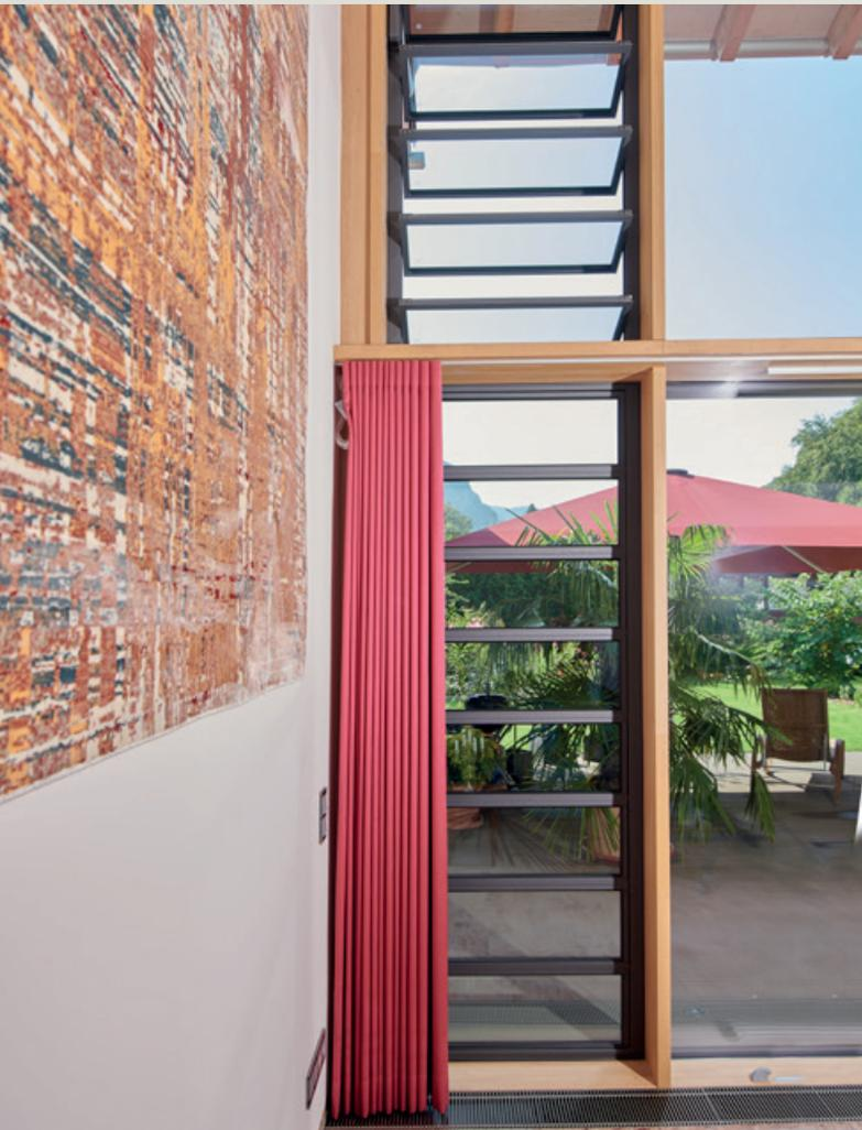
Das große FineLine-Element ist die Gestaltungsgrundlage für ein offenes Wohnkonzept. Die zweigeschossige FineLine-Konstruktion mit den zentralen Hebe-Schiebe-Anlagen unterstützt die Galeriebauweise im Innern perfekt und öffnet die innenliegenden Räume komplett nach außen.
